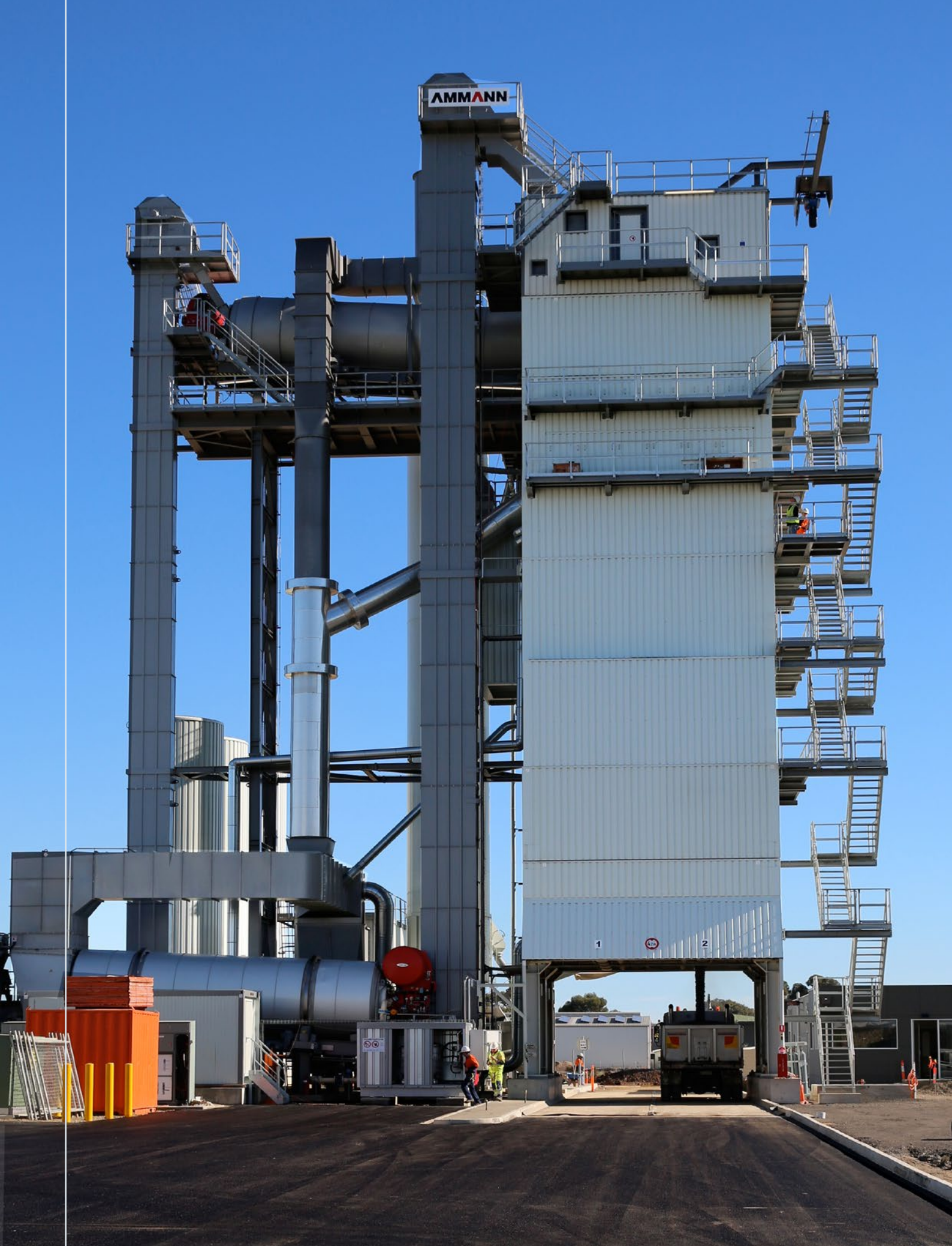
Poste d'enrobage Universal HRT avec tour de malaxage encapsulée, équipé d'un tambour parallèle pour l'ajout d'une proportion d'enrobés recyclés pouvant aller jusqu'à 60 % environ. Alternative : poste d'enrobage Universal HRT avec tambour RAH100 pour l'ajout d'une proportion d'enrobés recyclés pouvant aller jusqu'à 100 %.
