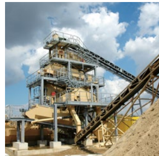
Installations de préparation des matériaux
