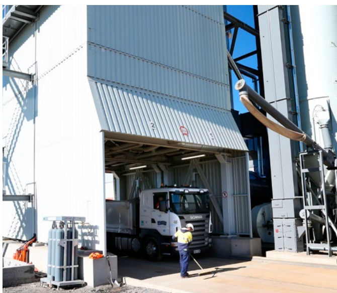
En option : encapsulage de silo de chargement avec aspiration des vapeurs de bitume.
